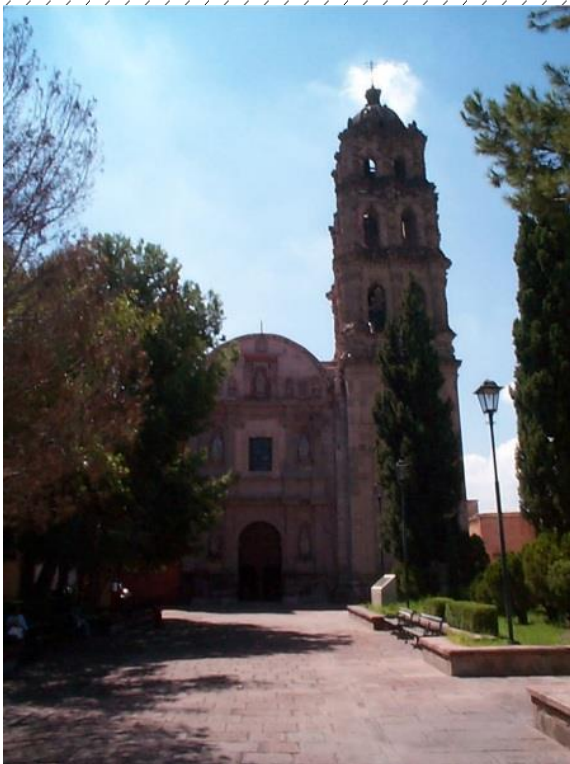
Vista general del inmueble
